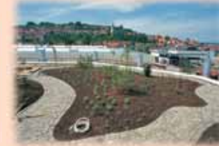
Een project kort voor oplevering. Plantvakken en verhardingen gaan hier op hetzelfde niveau in elkaar over.
