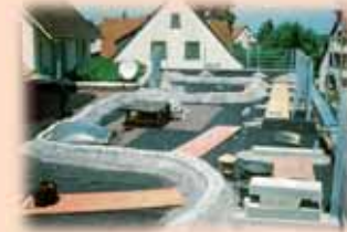
De doorgaande drainagelaag maakt een volledig vrij ontwerp van verschillende lijnen en richtingen mogelijk.
