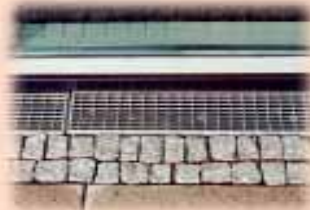
In het ontwerp flexibel, in de uitvoering duidelijk: het thema toegangen tot het dak. Hier opgelost met de terras- en gevelrooster als regelmatig toegepaste uitzonderingsconstructie om de toegankelijkheid te waarborgen.
